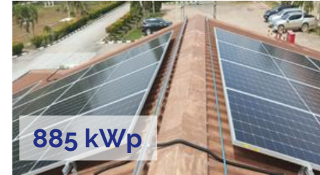
Perusahaan Migas (Sumatera Selatan)
