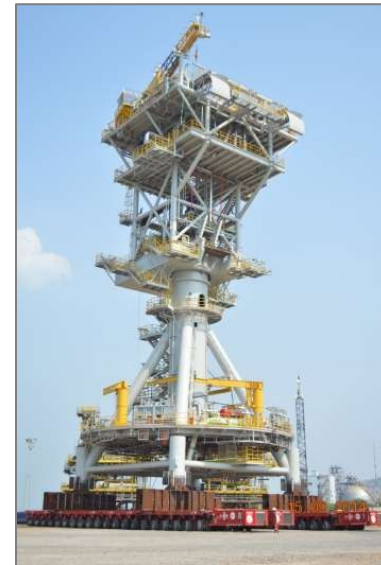
Mooring Tower – difabrikasi oleh BMI untuk Mobil CEPU, diinstalasi pada Laut Jawa (36km sebelah Utara kota Tuban).
